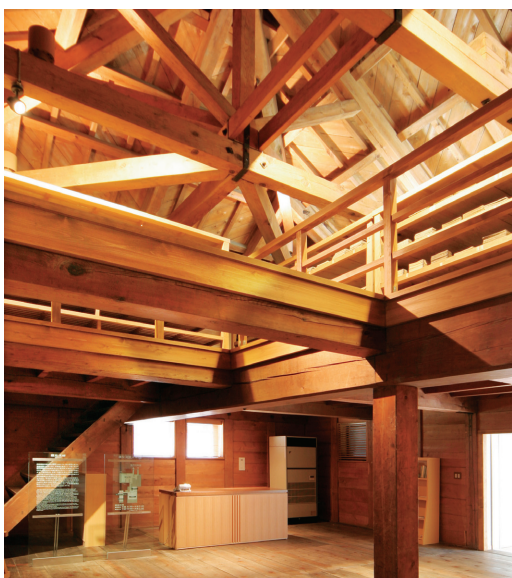
エントランスホール(旧書庫)
